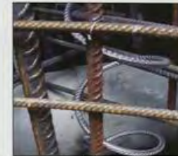
Abb. 3-2 Eingebaute Spirale, die als Rüttelgasse dient [Foto: PERI]
