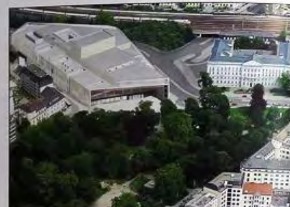
Abb. 9.30 Veranstaltungsgebäude - Musiktheater Linz [Copyright: Terry-Pawson-Architect]
