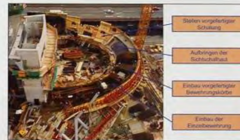
Abb. 3-3 Bauablauf beim Mercedes Benz Museum in Stuttgart [Foto: PERI]
