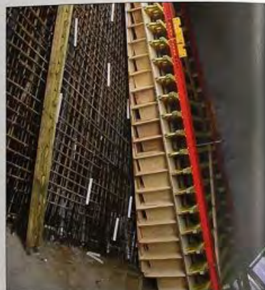
Abb. 3-1 Vordefinierte Rüttelgassen für das Verdichten des Betons [PERI 1) ]
